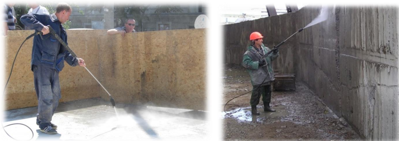
Рис. 2 – Очистка и увлажнение поверхности гидромонитором
