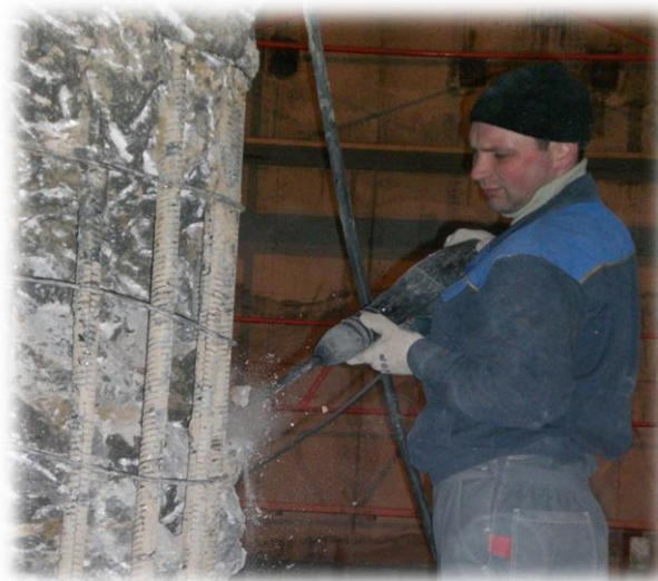
Рис. 1 – Удаление с поверхности поврежденного бетона
