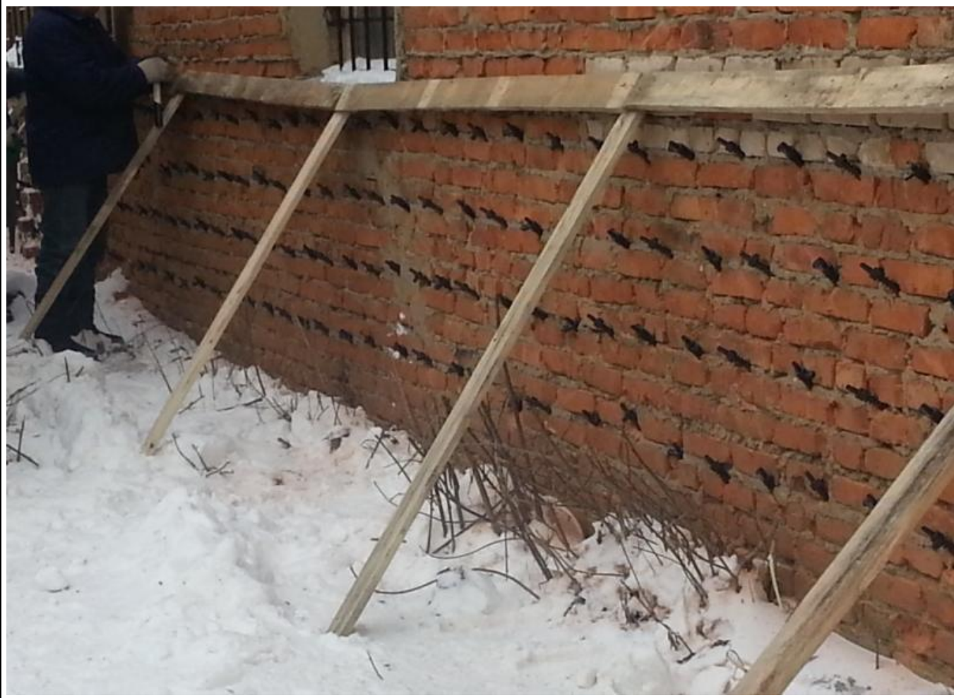
Рисунок 20. Инъектирование в кладку без множественных трещин
