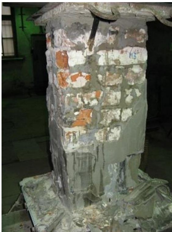
Рисунок 17. Испытания кладки из исторического кирпича, отобранного после усиления инъекцией
