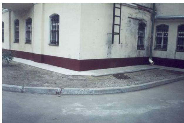
**Рис. 2. Техническое состояние кирпичной кладки после воздействия капиллярного подсоса: слева – до реставрации; справа – после реставрации (цоколь и отмостка выполнены составами с добавкой «Кальматрон»)**
