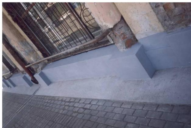
**Рис. 1. Техническое состояние цокольной части здания-памятника архитектуры: слева - до реставрации; справа - после реставрации гидроизолирующими составами с добавкой «Кальматрон»**
