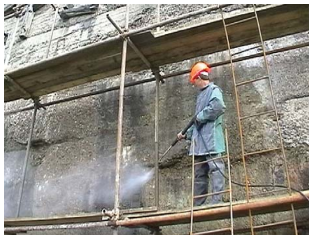
Рис. 2. Смачивание бетонных поверхностей
