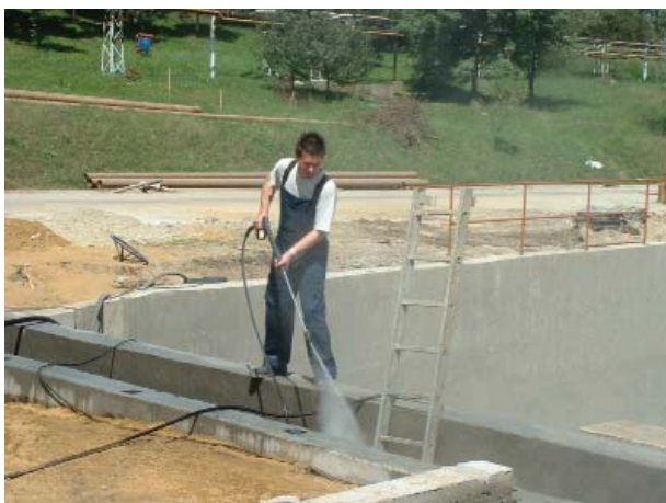
Рис. 1. Очистка поверхности гидромонитором
