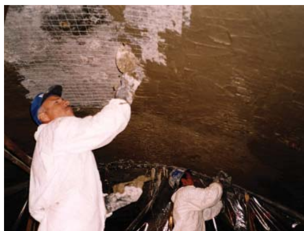
Рис. 6. Нанесение состава КАЛЬМАТРОН вручную
