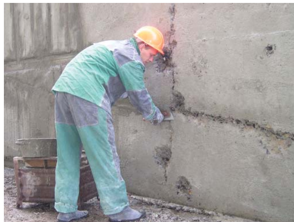
Рис. 4. Заделка трещин швов составом КАЛЬМАТРОН-ШОВНЫЙ
