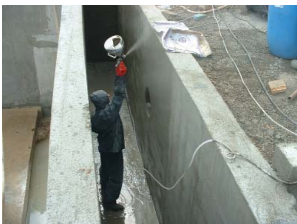
Рис. 5. Нанесение состава КАЛЬМАТРОН механизированным способом
